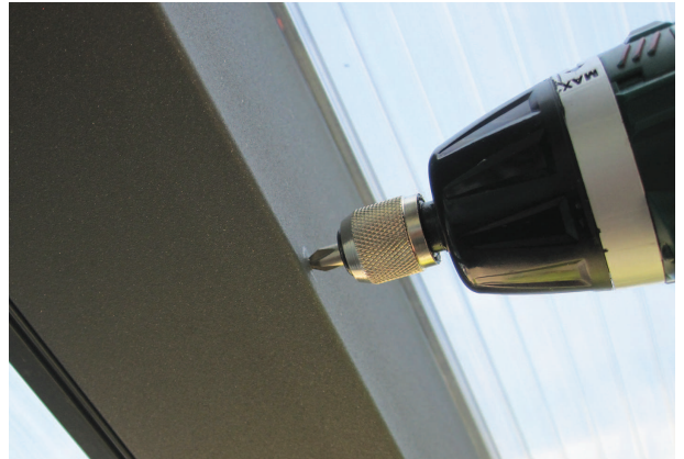
2.) Löcher in den Sparren vorbohren.
