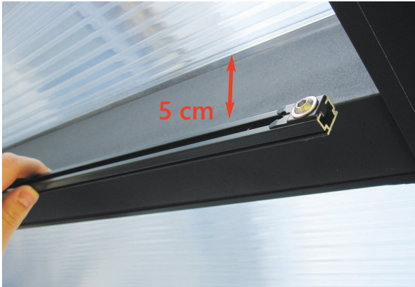
1.) Längsprofil an den Sparren halten, Löcher anzeichnen. Empfehlung: Alle 50 - 100 cm (Schiene ist alle 50 cm vorgebohrt)
