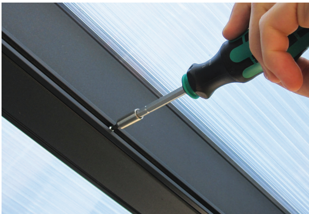
3.) Längsprofil anschrauben.
